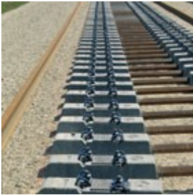
Traverses bi-blocs et leurs attaches (Photo JJ D'ANGELO)
