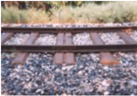
Traverses métalliques (photo DR)
