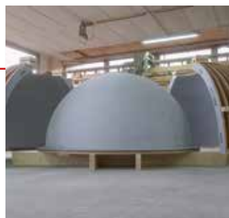
p. 36 – Sur chantier comme en unité de préfabrication, les moules et les coffrages permettent de donner leurs formes aux éléments coulés en béton.
