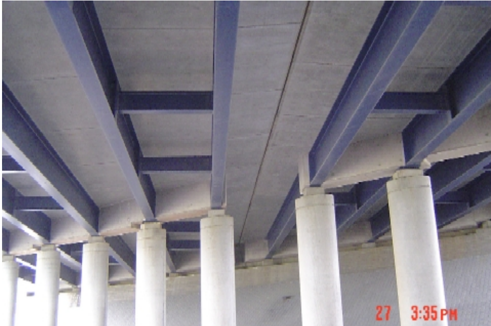
Pont mixte avec des HEA 1000 sur l'autoroute A13 au Luxembourg (Arcelor Long Products).
