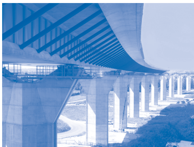
Le chantier du viaduc de Meaux.
