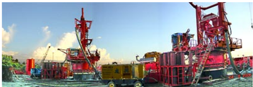
Vietnam, fondations d'un pont sur très gros pieux (Droits BSG)
