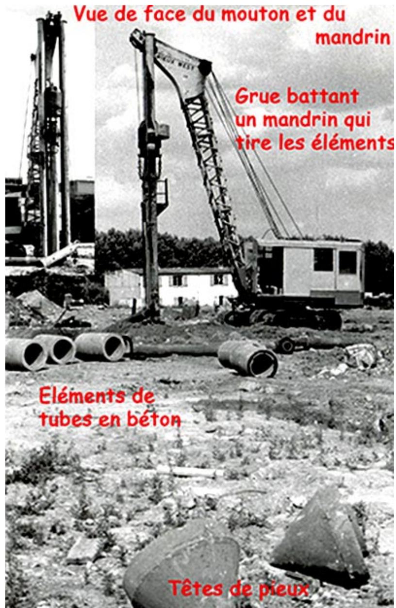
Pieux West (droits réservés)
