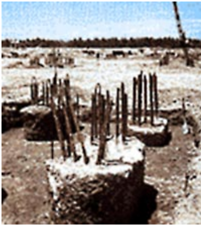
Têtes de pieux dégagées. On voit les fers en attente pour être reliés aux cages d'armatures des semelles (Droits réservés)
